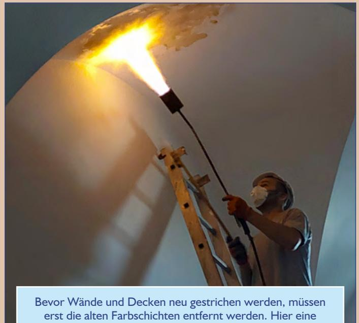
Bevor Wände und Decken neu gestrichen werden, müssen erst die alten Farbschichten entfernt werden. Hier eine erste Testphase an einem Gewölbe (20. Oktober).
