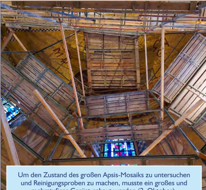
Um den Zustand des großen Apsis-Mosaiks zu untersuchen und Reinigungsproben zu machen, musste ein großes und mehrstufiges Gerüst gebaut werden (2. Oktober).
