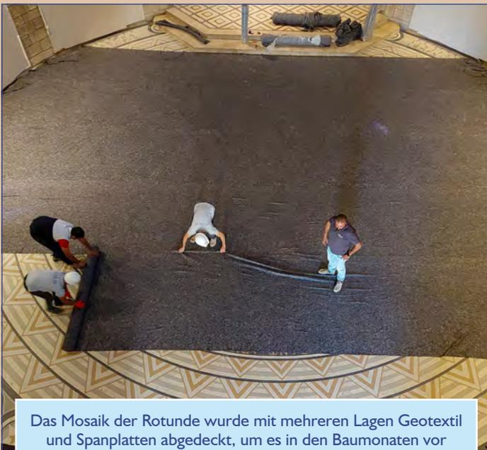
Das Mosaik der Rotunde wurde mit mehreren Lagen Geotextil und Spanplatten abgedeckt, um es in den Baumonaten vor Verschmutzung und Beschädigung zu schützen (4. Oktober).
