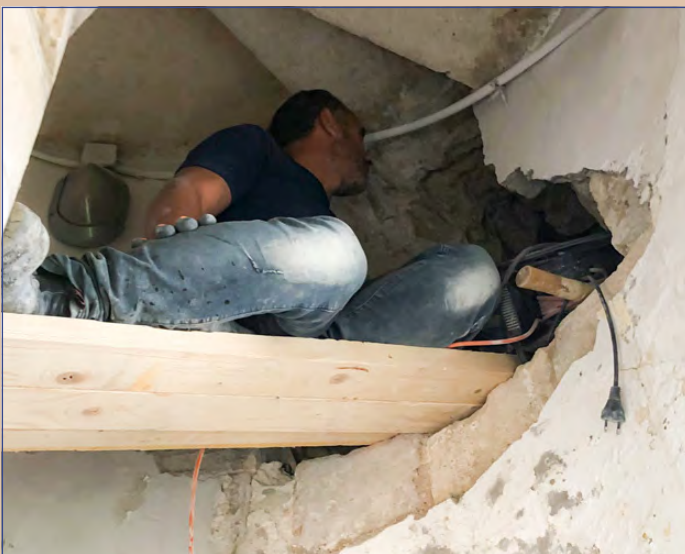
In einem der Treppentürmchen der Kirche musste ein besonders fieser Schaden einer alten, intern verbauten Regenrinne aufwendig repariert werden (4. November).
