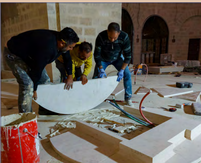
Vorsichtig setzen unsere Arbeiter mit Mörtel den innersten Altarkreis zusammen (28. November).
