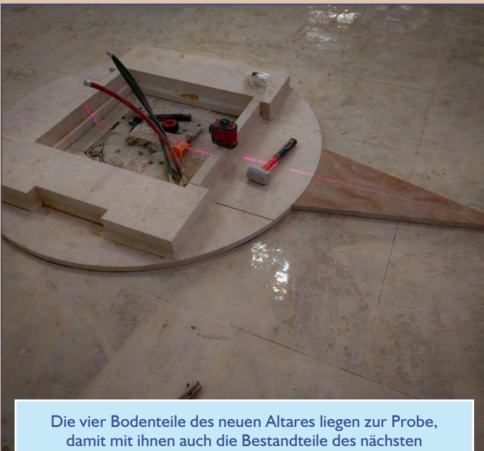
Dann markiert ein Laser-Kreuz die Mitte: Die Mitte unseres neuen Altares und die Mitte der Steinkreise, die sich um ihn legen (28. November).
