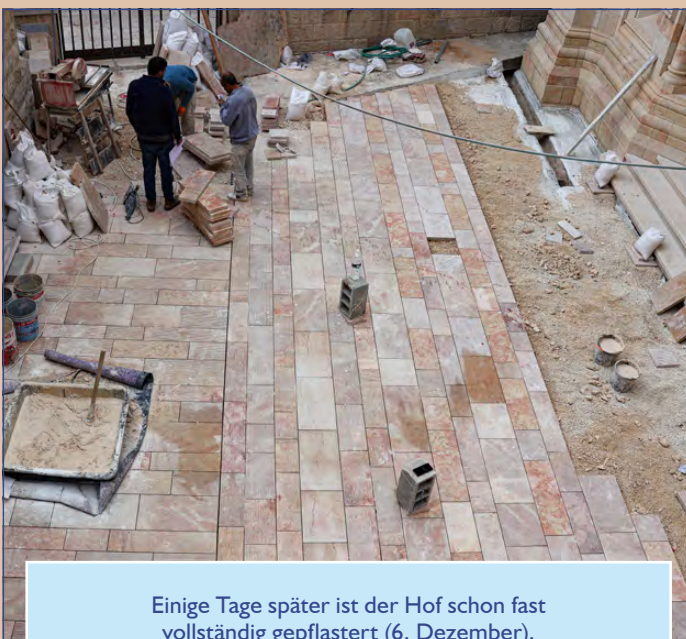
Und noch mehr stabiler Boden unter Mönchs- und Pilgerfüßen: Auch der Kirchenvorplatz wird neu mit Steinen belegt (30. November).
