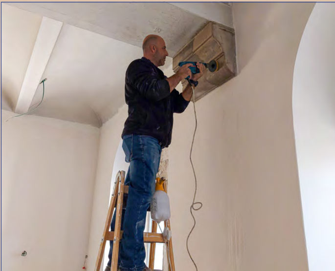
Unser Hausmeister Amjad reinigt mit Wasser und einer Bürste die Steinkonsolen im Refektorium. Der Unterschied links und rechts ist überdeutlich (18. November).
