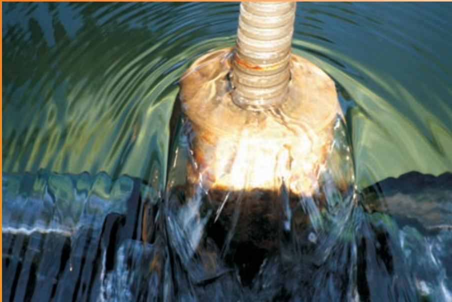
Detail der Poolschleuse im Garten von Tabgha Foto: Resi Borgmeier
