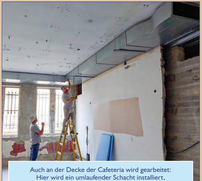
Auch an der Decke der Cafeteria wird gearbeitet: Hier wird ein umlaufender Schacht installiert, der ein Teil der künftigen Klimaanlage ist.
