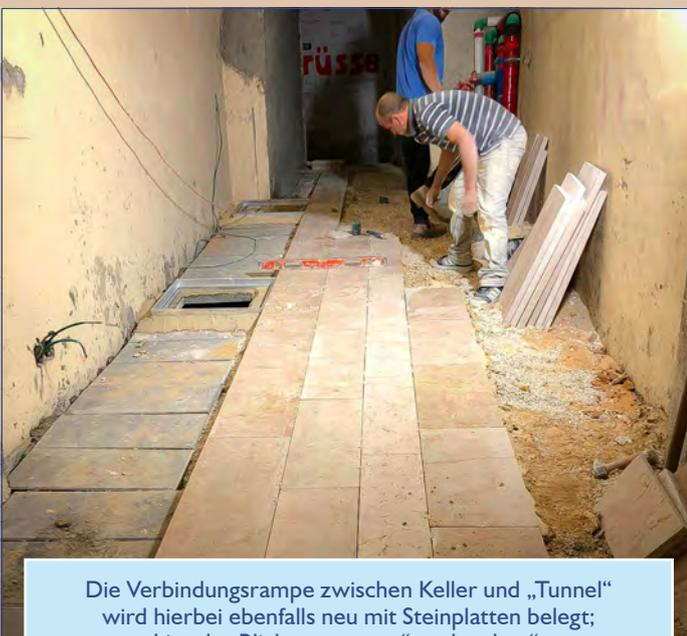
Die Verbindungsrampe zwischen Keller und „Tunnel“ wird hierbei ebenfalls neu mit Steinplatten belegt; hier der Blick von „unten“ nach „oben“.
