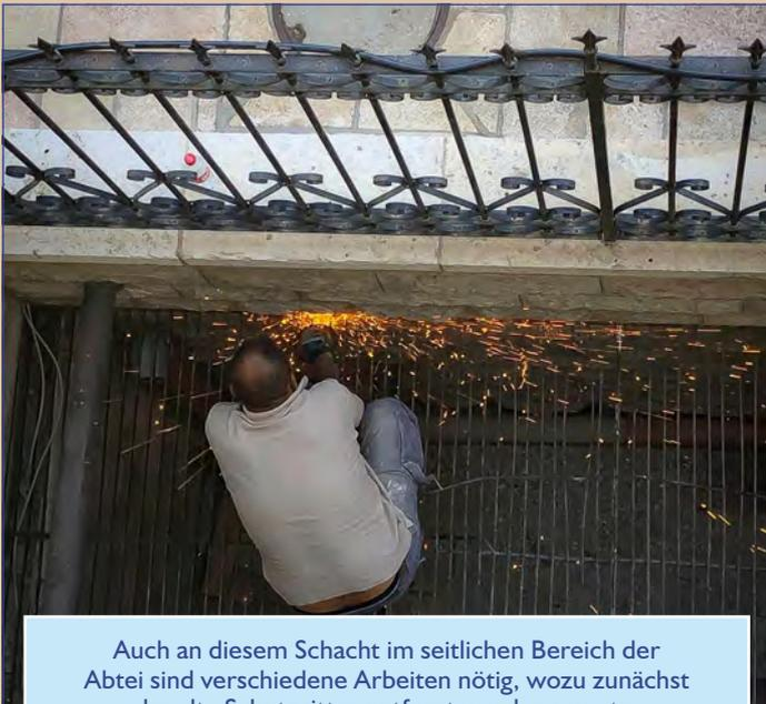
Auch an diesem Schacht im seitlichen Bereich der Abtei sind verschiedene Arbeiten nötig, wozu zunächst das alte Schutzgitter entfernt werden musste.
