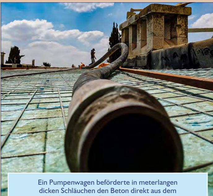
Ein Pumpenwagen beförderte in meterlangen dicken Schläuchen den Beton direkt aus dem Mischwagen drei Stockwerke nach oben.
