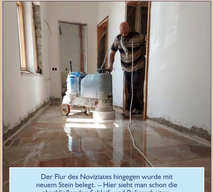
Der Flur des Noviziates hingegen wurde mit neuem Stein belegt. – Hier sieht man schon die abschließenden Schleif- und Polierarbeiten.
