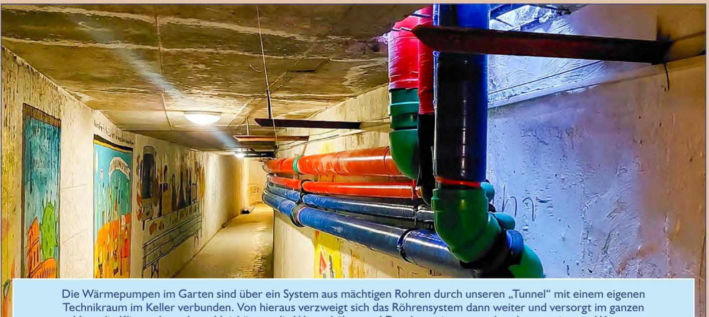
Die Wärmepumpen im Garten sind über ein System aus mächtigen Rohren durch unseren „Tunnel“ mit einem eigenen Technikraum im Keller verbunden. Von hieraus verzweigt sich das Röhrensystem dann weiter und versorgt im ganzen Haus die Klimaanlage bzw. Heizkörper, die Wasserhähne und Duschen mit entsprechend temperiertem Wasser.
