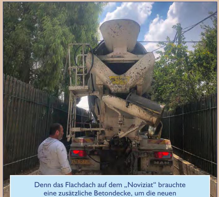
Denn das Flachdach auf dem „Noviziat“ brauchte eine zusätzliche Betondecke, um die neuen Isolierungsschichten besser zu schützen.
