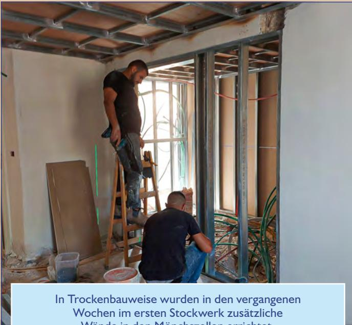
In Trockenbauweise wurden in den vergangenen Wochen im ersten Stockwerk zusätzliche Wände in den Mönchszellen errichtet.
