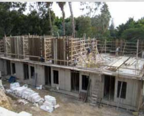
**Oben: Die zweite Etage des Zellentraktes wird geschalt. – Unten: Blick in eine künftige Zelle.**
