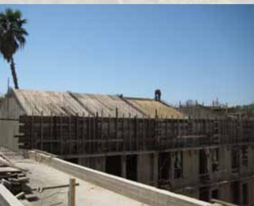
**Oben: Die Schalung des Daches am Zellentrakt entsteht. – Unten: Und schon fließt der Beton auf das Dach.**
